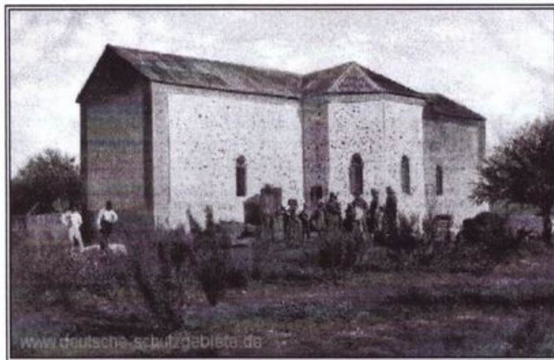
Deutsch-Südwestafrika - Zerstörte Kirche
